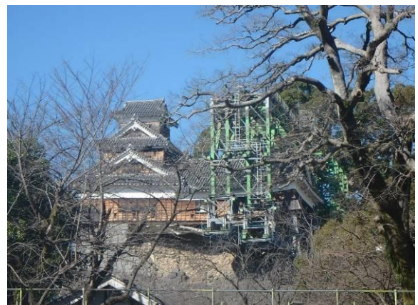
1) 現在の飯田丸五階櫓（建屋修復中：2月/2日撮影）
