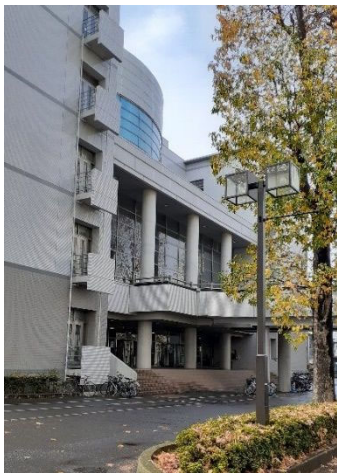
写真1 講義を行った16号館
