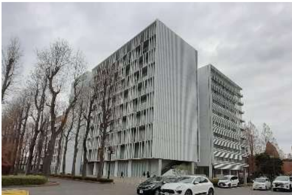
写真1 講義を行った19号館
